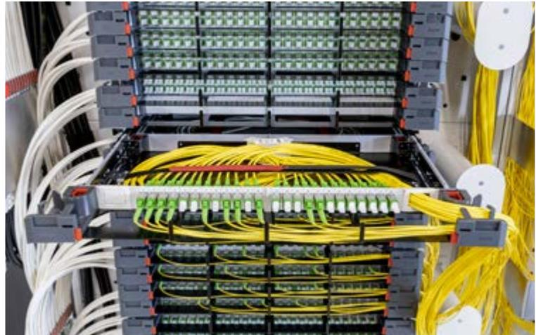
Dieses Beispiel zeigt einen ODF Prime in gespiegeltem Aufbau mit jeweils seitlichen Zugängen für von außen eingeblasene Verbindungen. Vorkonfektionierte Glasfaserverbindungen sorgen in diesem Fall für die Weiterleitung der Signale zum nächsten Verteilpunkt / Aktivgerät. Die Umlenkrollen im mittleren Bereich sorgen für eine aufgeräumte und einfach zugängliche Patchverkablung, die nach oben über unser Raceway-System weggeführt wird.
